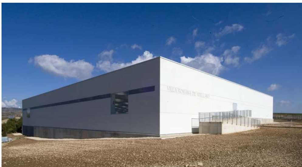
Figura 4. Vista del edificio desde el suroeste
