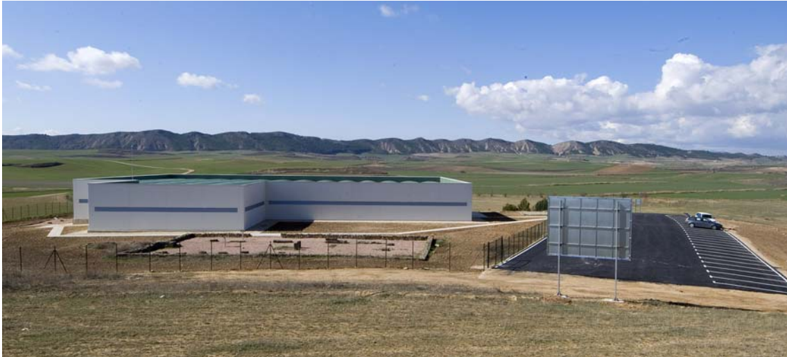
Figura 9. Vista general de las instalaciones
