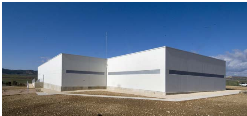
Figura 5. Vista del edificio desde el sureste
