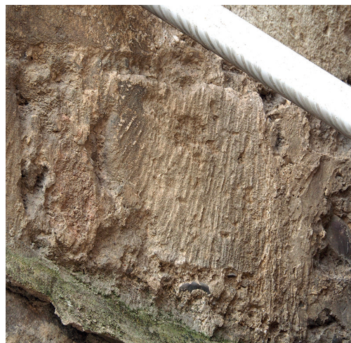
Figura 11 Bloque con labores de trazos oblicuos, para encastrar la pieza en el muro
