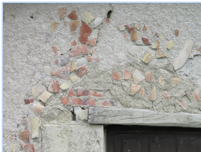
Figura 6. Palomar en Matallana (Villalba de los Alcores, Valladolid). Piedra, barro, ladrillo, madera. Combinación desprejuiciada de materiales diversos en el vernáculo histórico [©Javier Pérez Gil]
