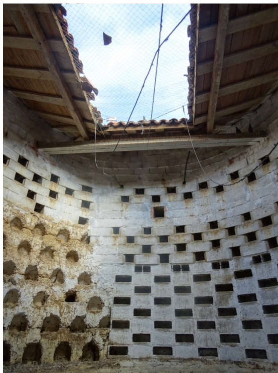
Figura 7. Interior del palomar, con nichos de barro y hormigón. Julio de 2018 [©Javier Pérez Gil]
