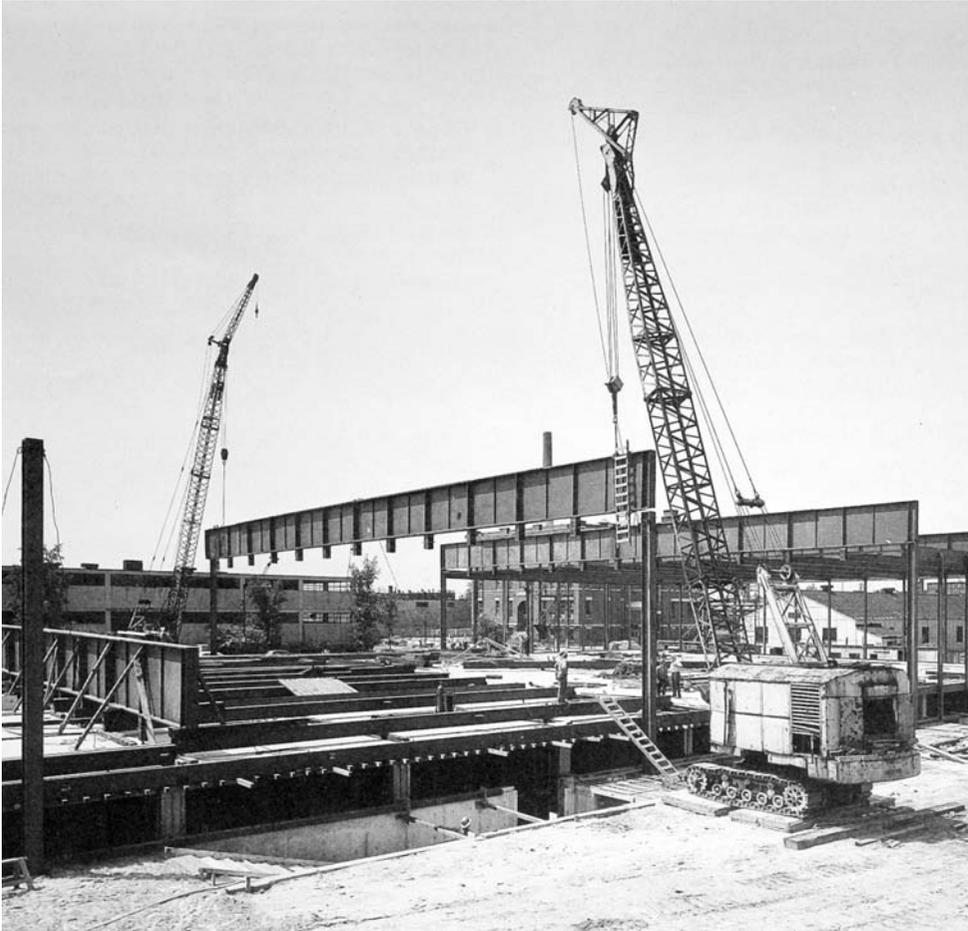
Fig. 15. *Crown Hall*. ITT de Chicago. Chicago, 1950-1956. Montaje de las vigas de la estructura. Arq. Mies Van der Rohe.
