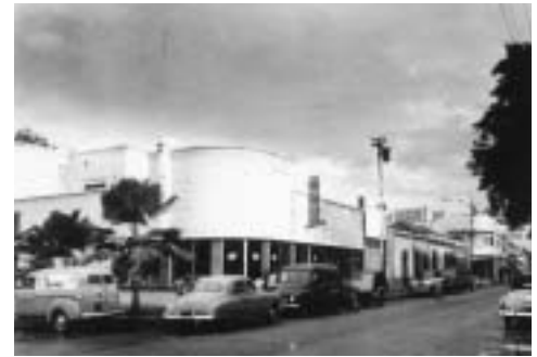
Fig. 9. Minimax , Valencia, Venezuela. El Minimax de IBEC en Valencia ilustra la progresión del diseño para tiendas. El delineado de la fachada sobre la entrada a la tienda concuerda con el diseño de los automóviles en esta calle. La situación de los automóviles era esencial para el diseño y estrategia de marketing de IBEC en la región (fotografía cortesía de The Rockefeller Archives Center , 1950, Meyn).
