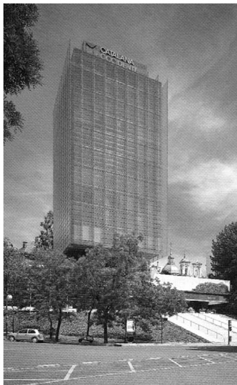
Fig. 10. Edificio Castelar, Madrid, 1975. Rafael de La-Hoz. En: Arquitectos n. 158 vol. 01/2, p. 138.
