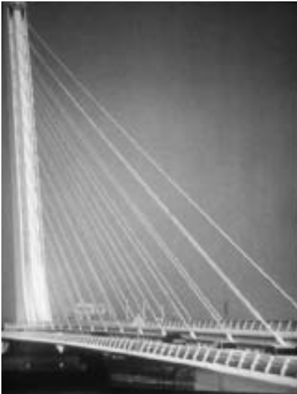
Fig. 18. Puente del Alamillo. Sin la metáfora que constituye a la imagen visionaria, la síntesis final de los materiales y los actos constructivos dejaría de tener la presencia viva de la imagen y sería sólo un fantasma o producto de la fantasía.
