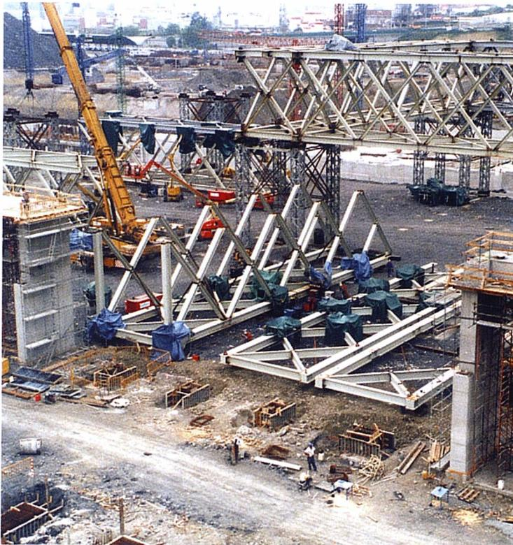
Fig. 3. Montaje e izado de jácenas
