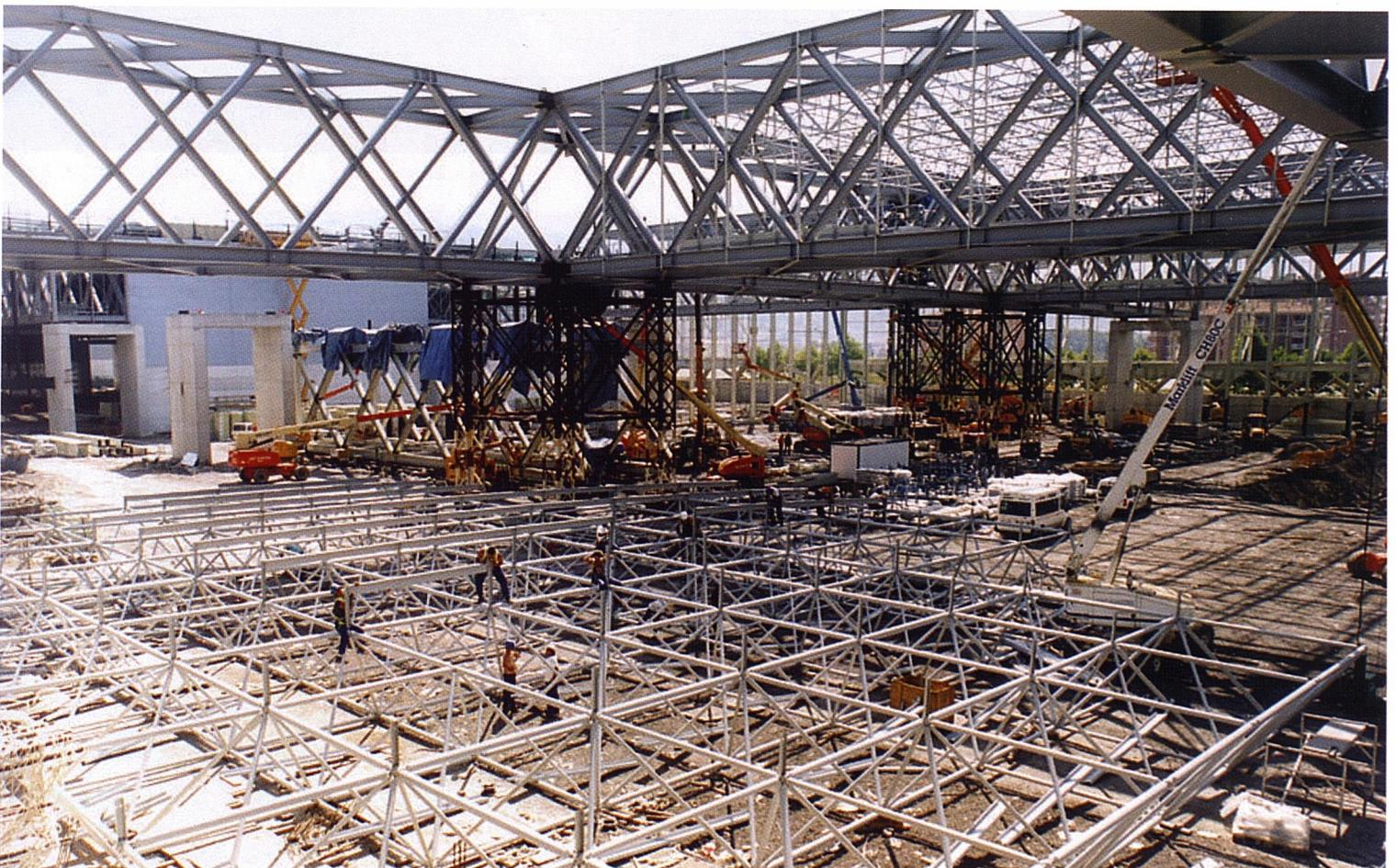
Fig. 5. Montaje de la malla
