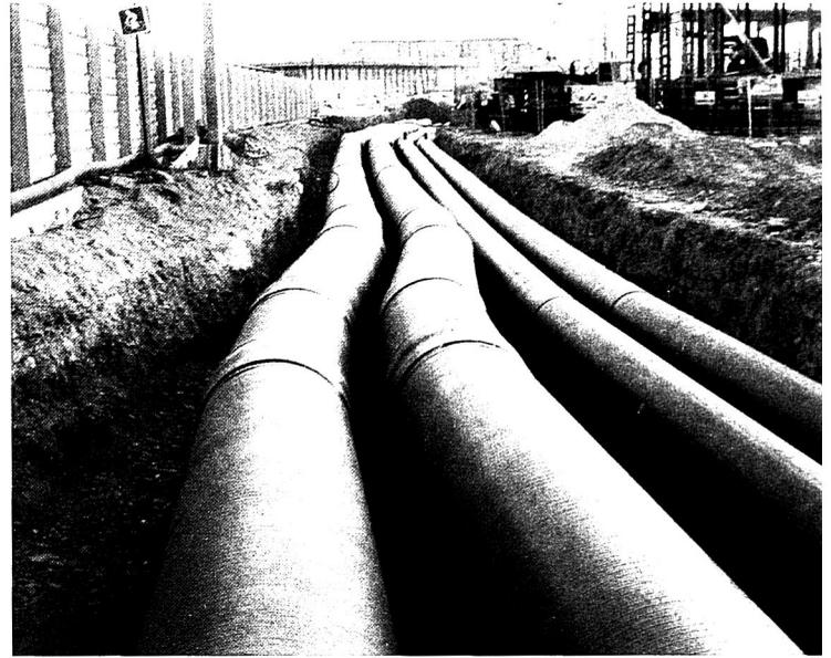
Tendido de las cuatro tuberías de las redes de calefacción y refrigeración
