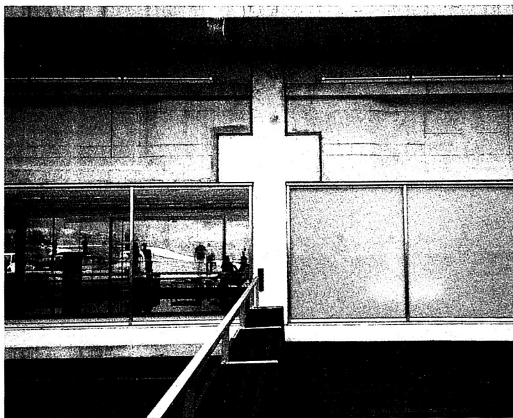
Apoyo de las vigas
