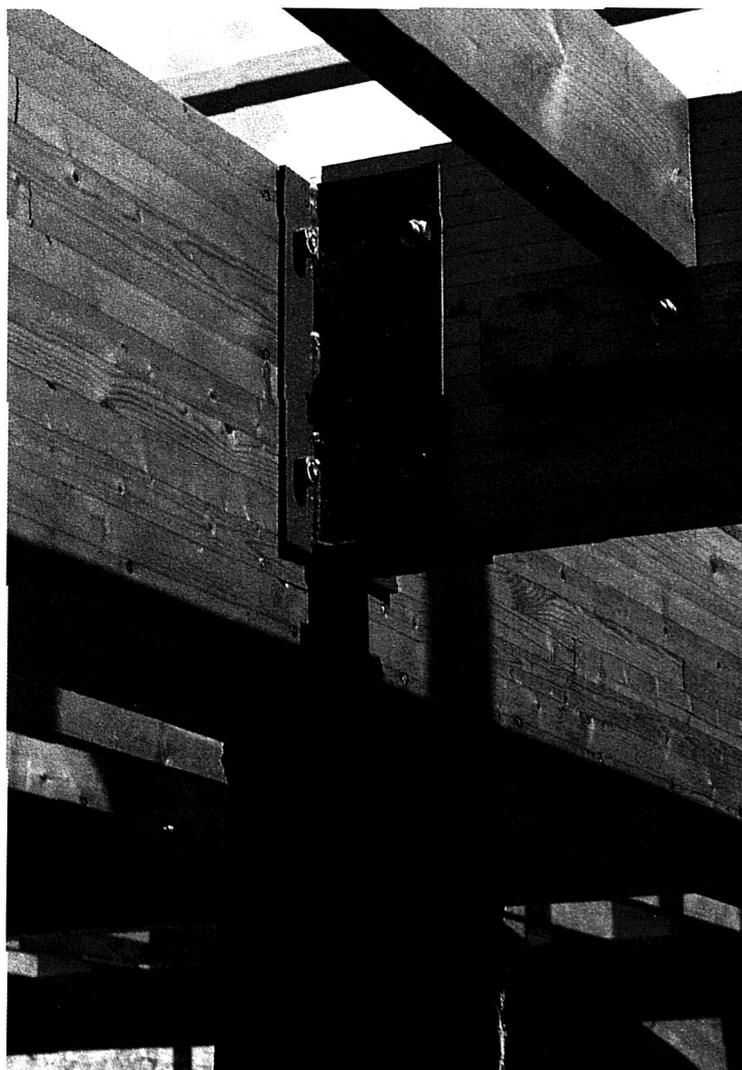
Unión mecánica mediante herraje
