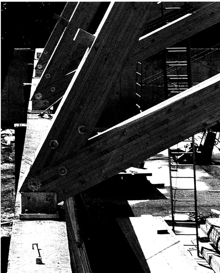
Ejemplo del montaje de pilar de pórtico mediante herraje singular
