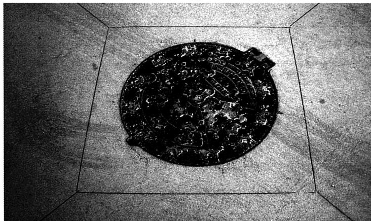
Detalle de cortes de solera junto a tapa de pozo de registro correctamente ejecutados
