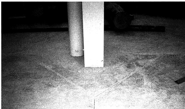
Detalle de cortes de solera junto a pilar correctamente ejecutados
