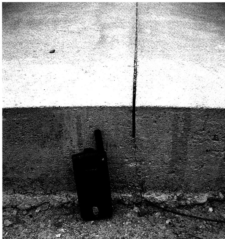
Detalle de sección de solera: corte aserrado y fisura inducida
