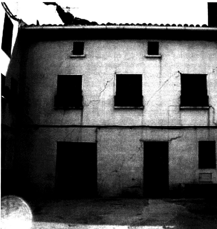
Patología por colapso en una vivienda situada en el pueblo de Mendoza. Véase la dirección izquierda-derecha del movimiento
