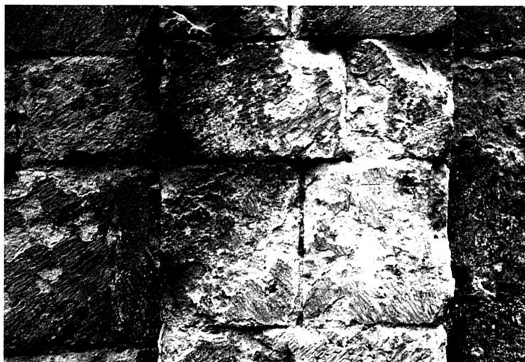
Fig. 2. Detalle de la fina capa de mortero de cal que protege y embellece la fábrica de sillaría del ábside
