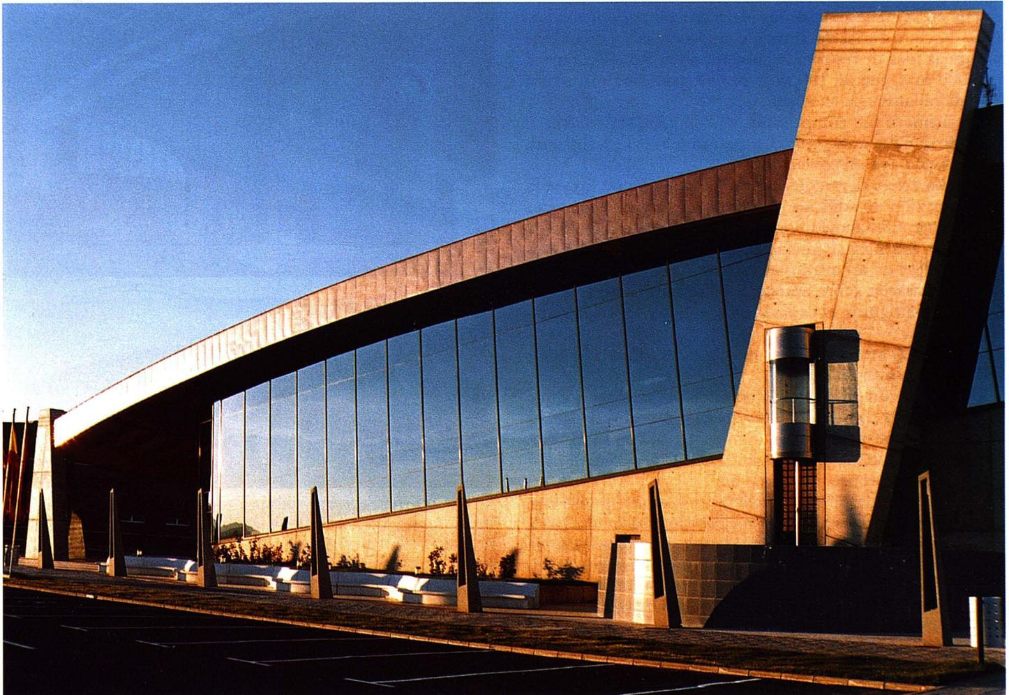
El edificio que alberga el Recinto Ferial de Teruel (figura 1) tiene su cubierta con forma de caparazón, construido sobre una estructura de madera laminada encolada (figuras 2 y 3.)
